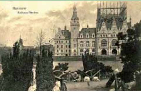
Abb. 13 Das Alpinum mit Knüppelholzgeländen, im Hintergrund das im Bau befindliche Rathausgebäude, vor 1908
